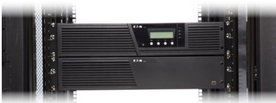
Rys. 3. Jednofazowy zasilacz UPS serii 9130 z dodatkową baterią, zainstalowany w szafie serwerowej.
